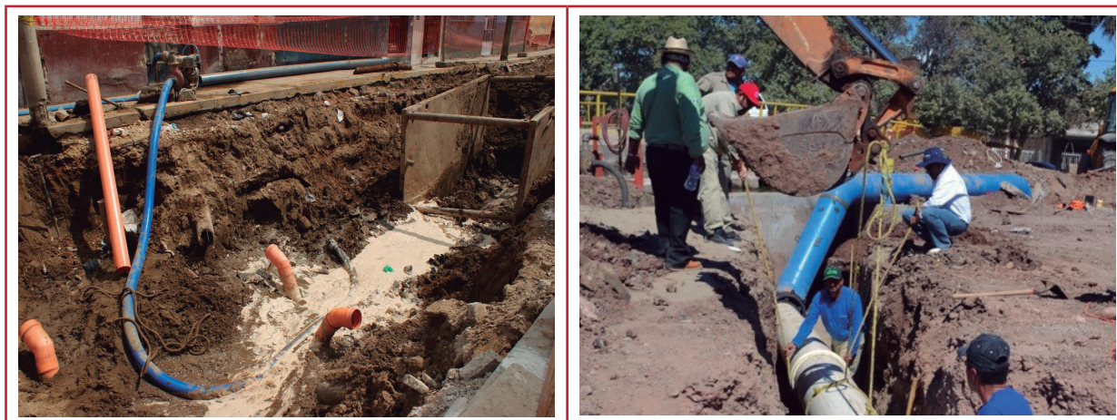
Ilustración 2.11 Obras de desvío para tubería de agua potable
