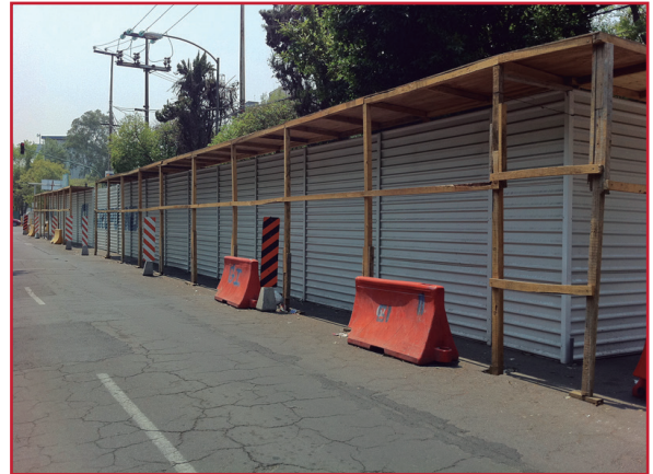
Ilustración 2.10 Tapial para protección de obra
