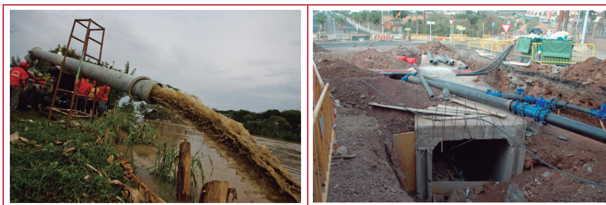
Ilustración 2.12 Obras de desvío para drenaje pluvial
