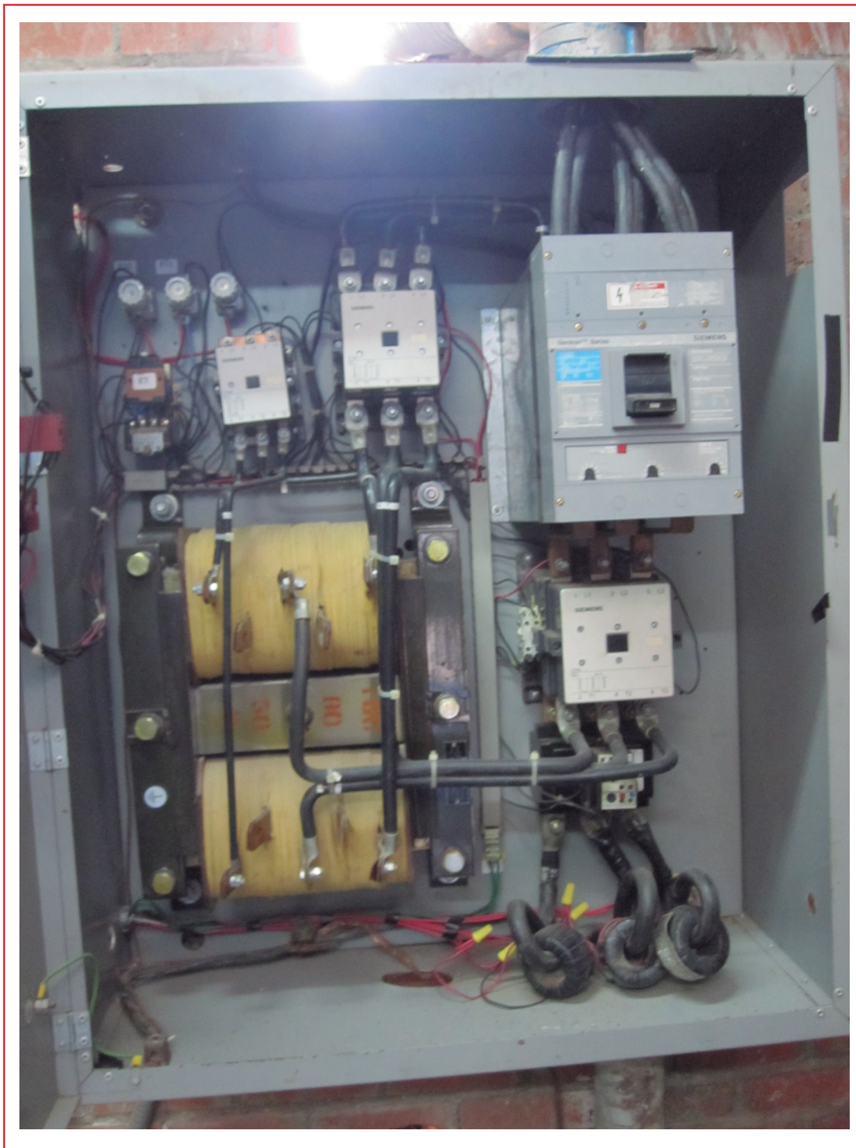
Ilustración 2.44 Arrancador
