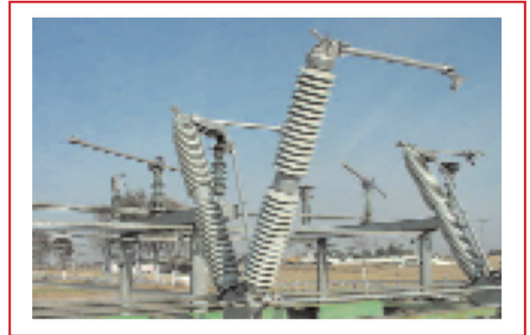
Ilustración 2.27 Cuchilla de apertura lateral central (DRV) para distribución y transmisión
