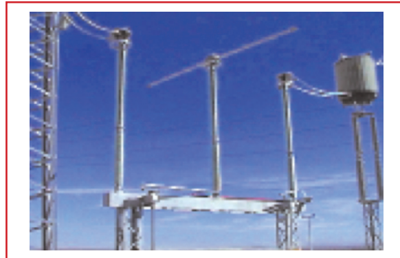
Ilustración 2.28 Cuchilla de doble apertura lateral central
