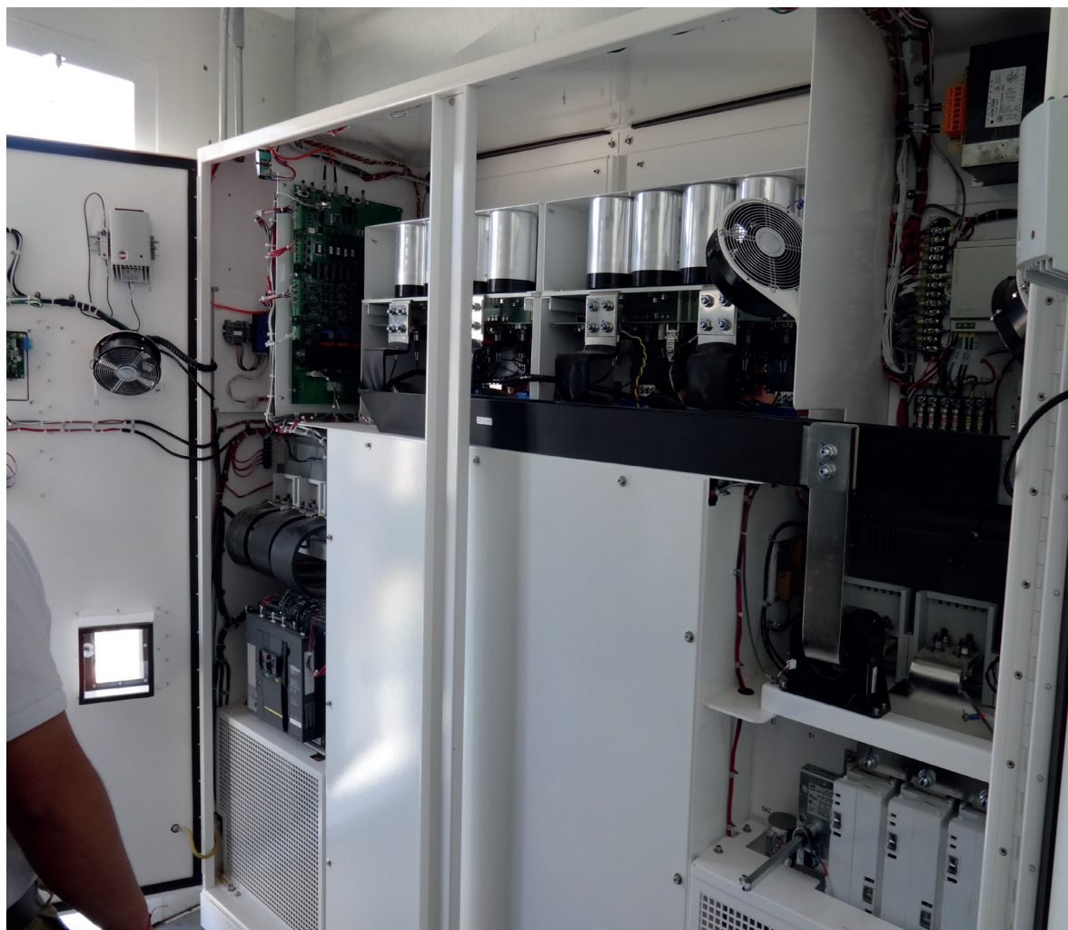
Ilustración 2.32 Variador de velocidad
