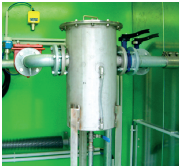
Ilustración 4.10 Trampa de condensados
