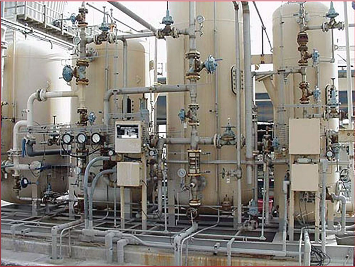
Ilustración 3.42 Sistema de ablandamiento mediante intercambio iónico
