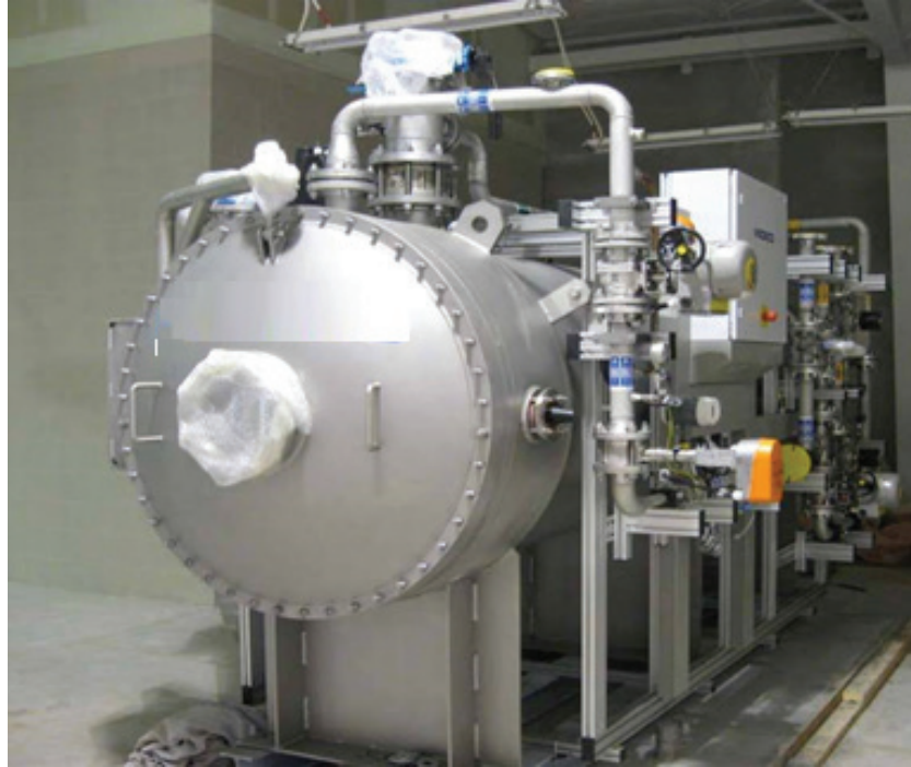
Ilustración 6.5 Cámara de contacto en tres etapas con difusor de burbujas
