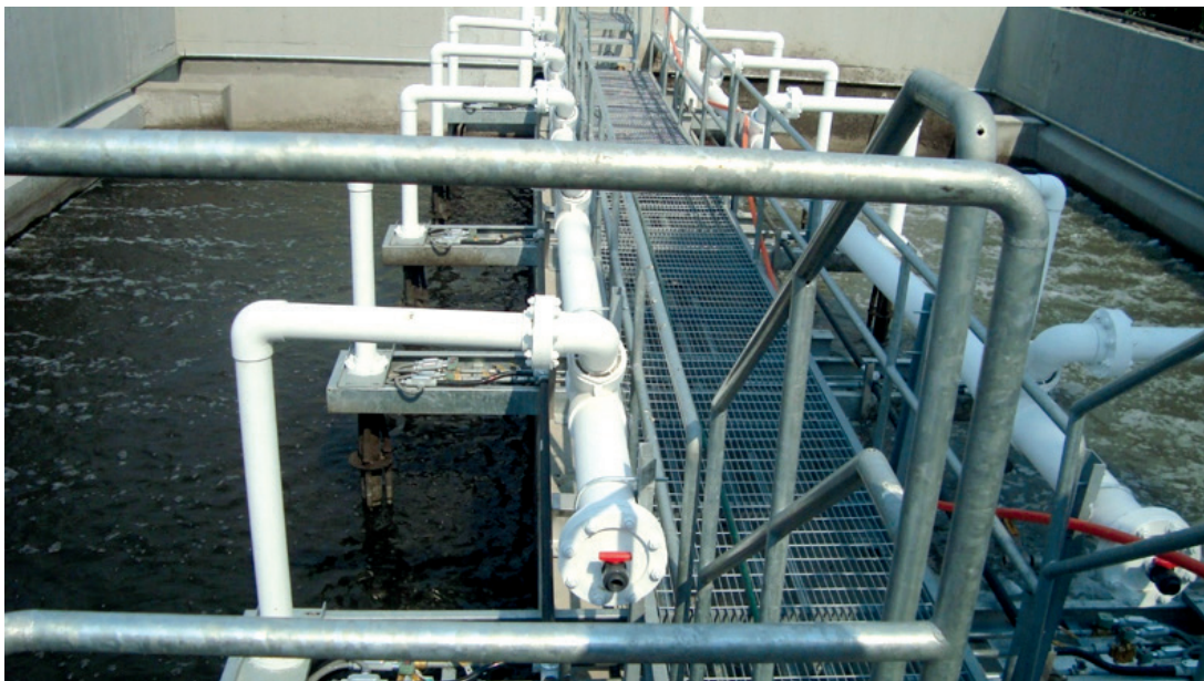
Ilustración 1.8 Desarenador aireado
